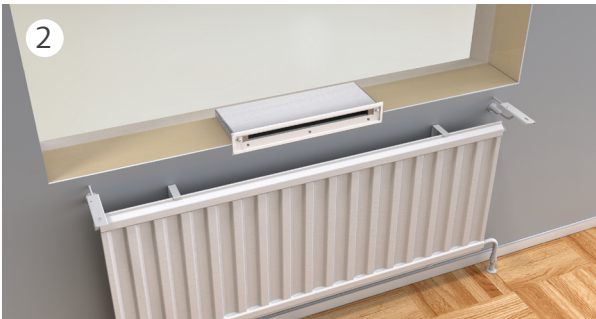
2 Lägg kanalen på plats med drevning under. Det är viktigt att kanalen är placerad högre upp än fönsterbänkskonsolerna. Skruva fast kanalen i insida vägg med 3 skruvar. Använd skruv med platt skalle så att listen kan täta helt mot luftdonet
