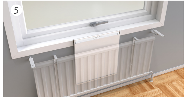
5 Tag av luftdonets filterlucka. Häng donet på de två skruvarna på kanalen. Skruva åt så att listen tätar mellan kanal och don. Lägg i luftfiltret i donet. Luftdonets underdel bör hamna minst 30 cm nedanför radiatorns ovkant
