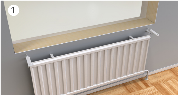
1 Demontera befintligt fönster och rengör fönsteröppningen
