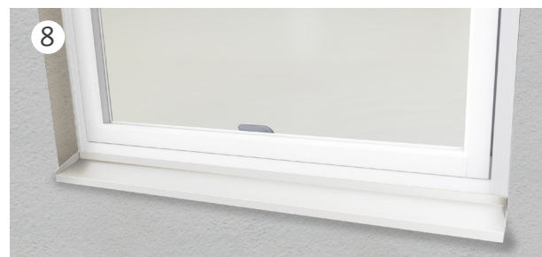
8 Slutligen monteras fönsterbleck och utvändiga smygplåtar
